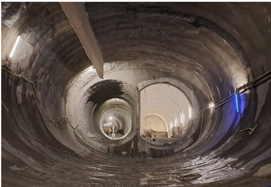
Abb. 2: Das Aufweitungsbauwerk der Fahrtrichtung Ulm bzw. Böblingen nach den Vortriebsarbeiten. In der rechten abzweigenden Röhre des Pfaffensteigtunnels ist bereits die Innenschale hergestellt Quelle: ARGE BÜ S21 PFA 1.3a
